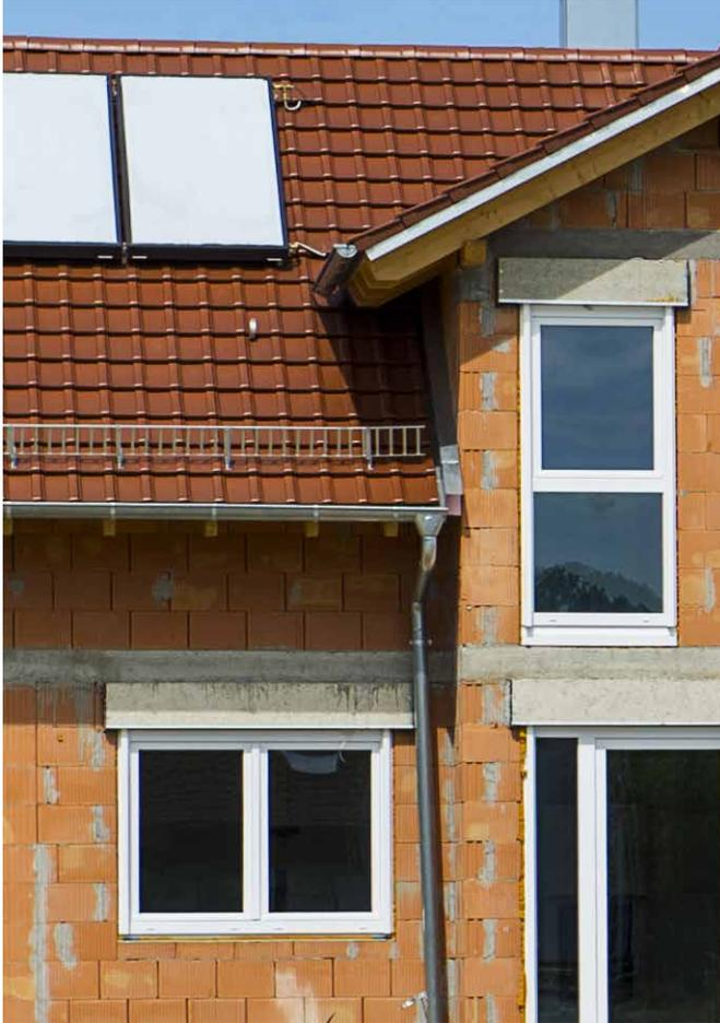
Neubau-Auflagerkasten: Ansicht im Rohbau montiert
